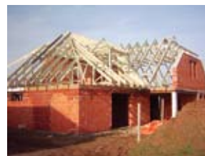
4. Rekonstrukce plochých střech sedlovými nástavbami
